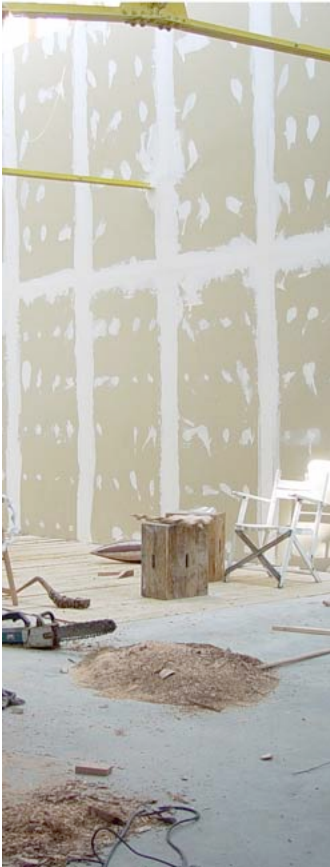
En chantier, vue d'atelier
